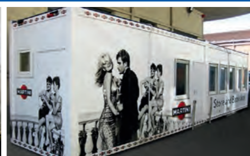
Торговое помещение из 2-х блок-контейнеров
