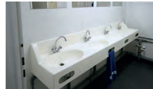
Лоток с двумя или четырьмя умывальными раковинами
