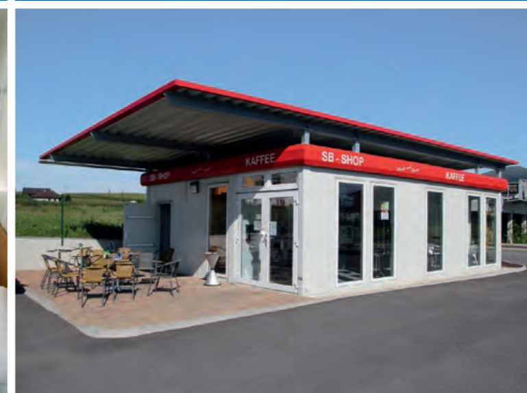
Магазин на заправочной станции
