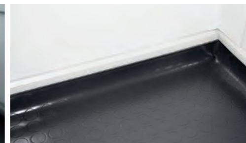
Нескользкое напольное покрытие ПВХ (в форме ванны)
