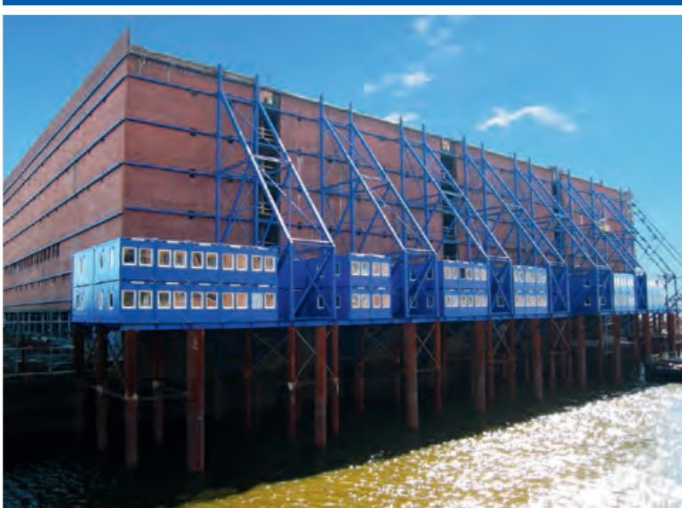
Строительный офис на площадке в особых условиях
